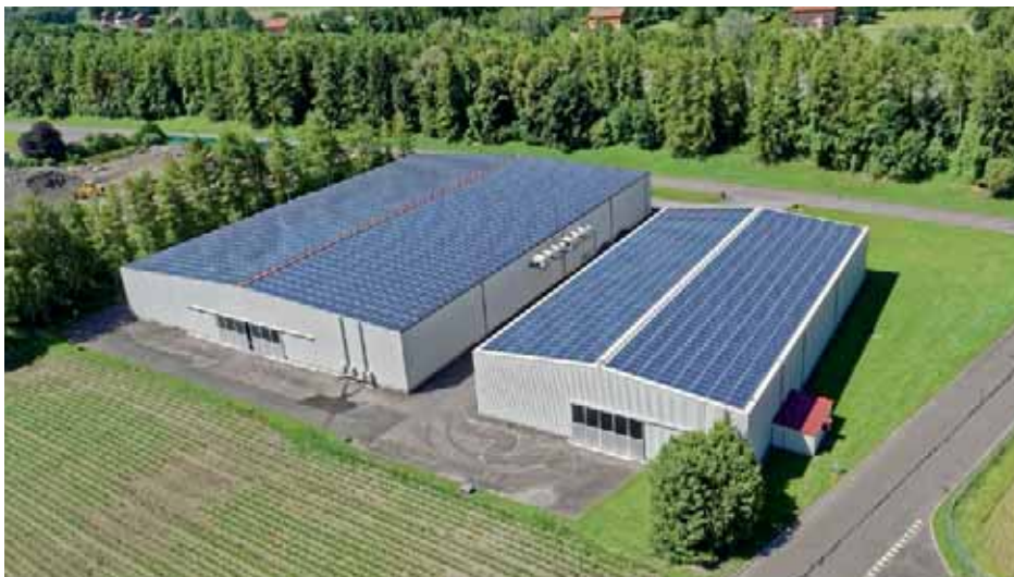
Die neue Photovoltaikanlage auf den Dächern der EFA in Aigle. EFA dans sa globalité.
