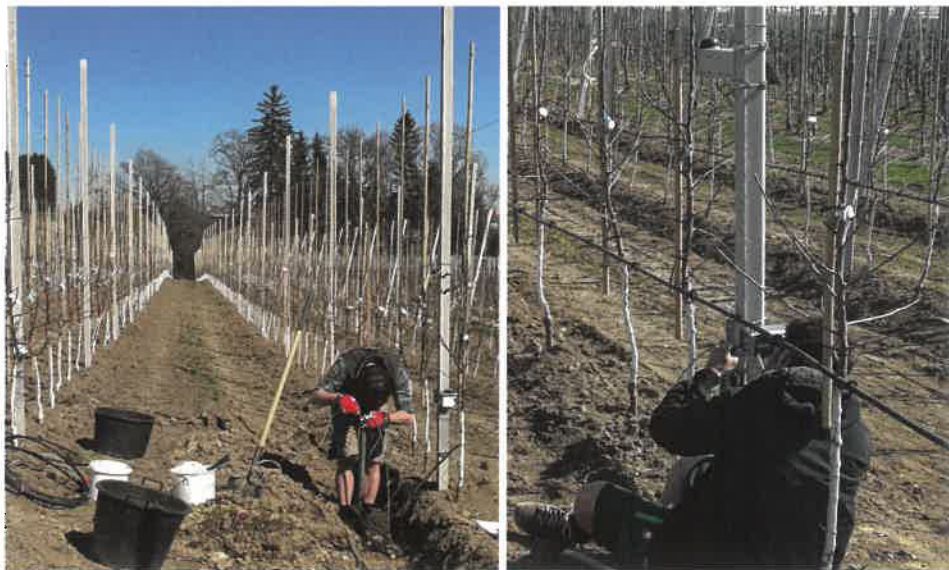
Installation der Sensoren zur kontinuierlichen Messung der Saugspannung und des volumetrischen Wassergehaltes, hier in 20 und 40 cm Tiefe am Standort Schlachters.
