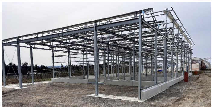
Abbildung 1: Stahlbau des Forschungsgewächshauses – R. Bischoff
